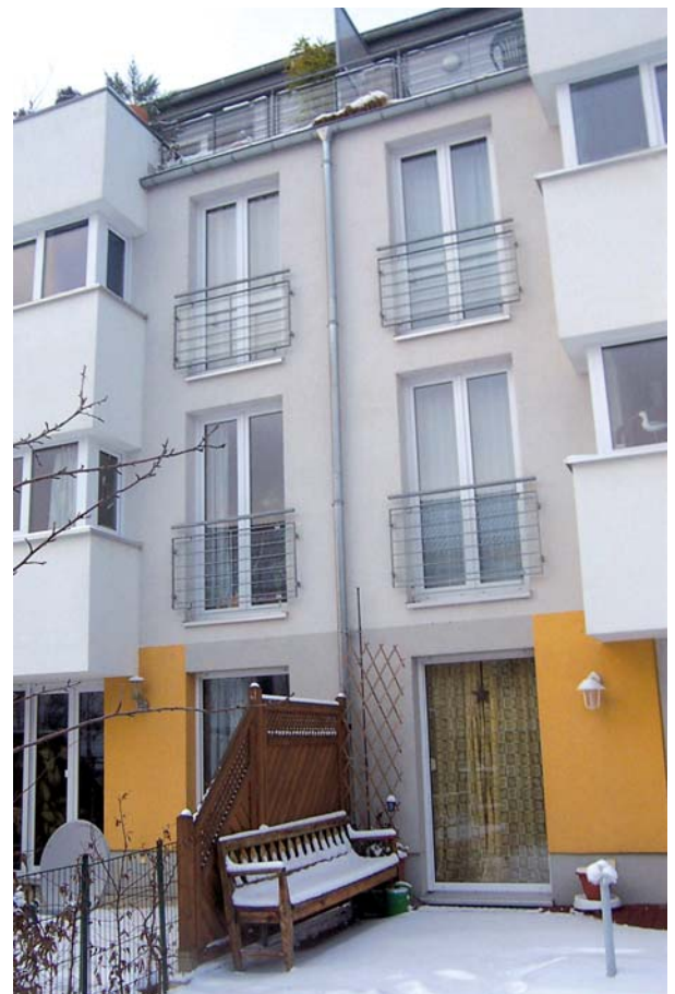
Dachrinne als unauffällige Amateurfunkantenne
